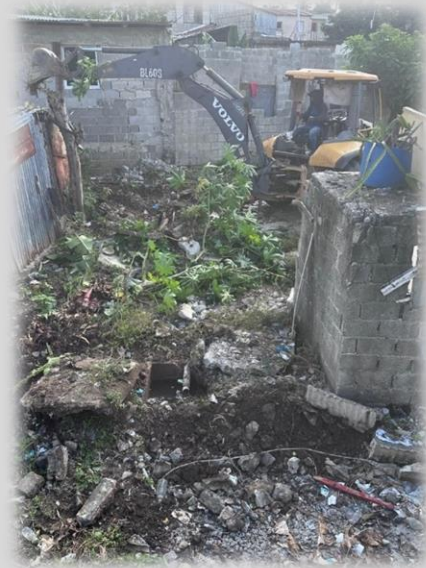
Ilustración 2. Limpieza y Nivelación del terreno
